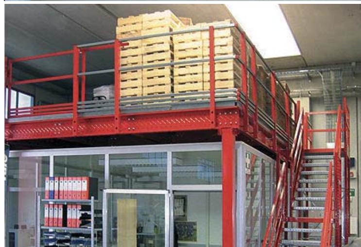
SOPPALCO CON PARETI UFFICI
